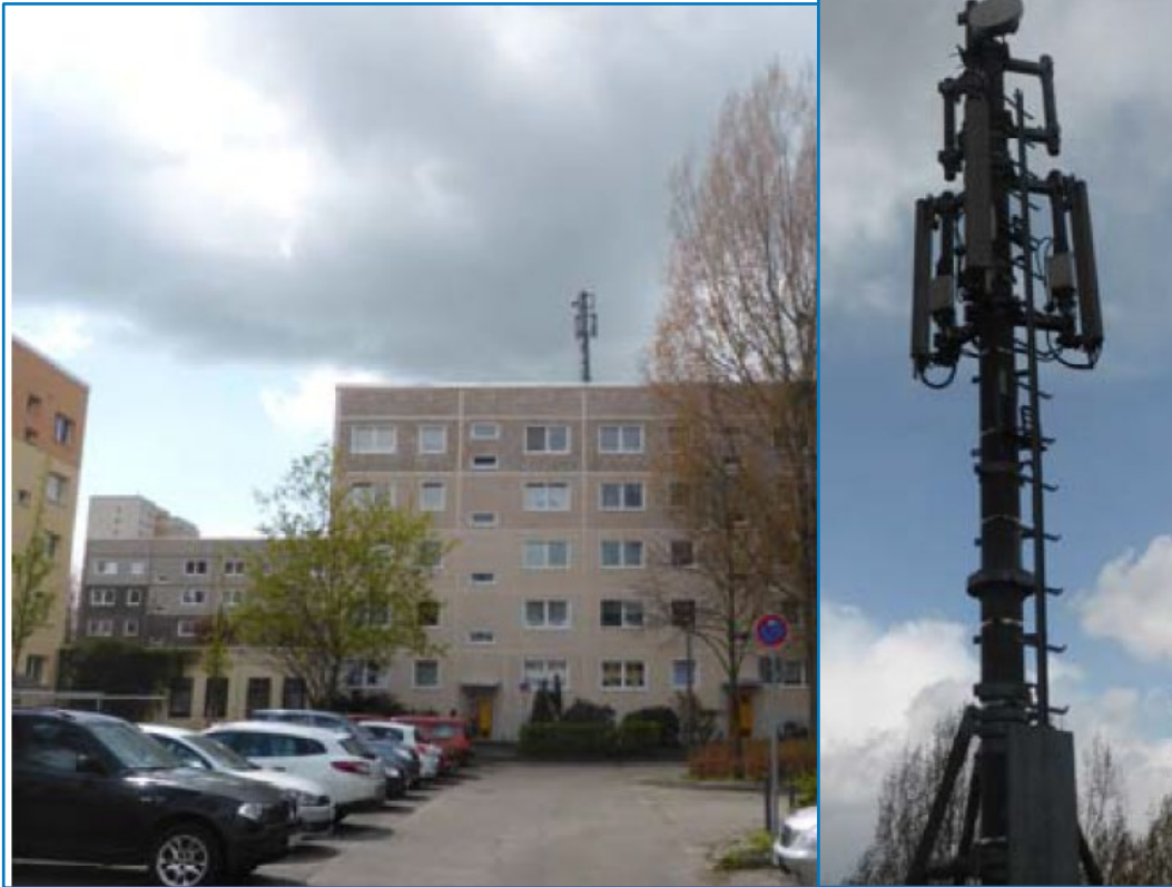
Antennen auf dem Dach des Gebäudes installiert
